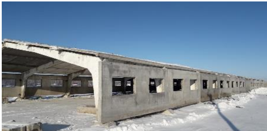
Строительство нового коровника на 250 голов ООО «Раздольное»
