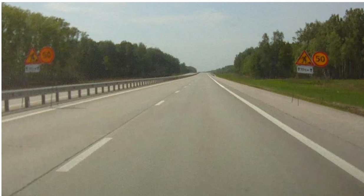
Рисунок 1.6 – Участок АДОПФЗ Р-254 с неубранными временными ТСОДД на 1406 км трассы (долгота 55,072711, широта 82,145968)
