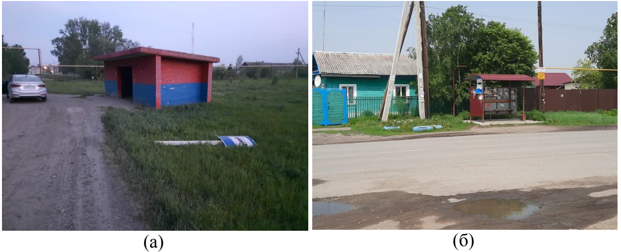
Рисунок 1.23 – Примеры дорожных знаков 5.16 в ненормативном состоянии: а – в п. Речник; б – с. Прокудское
