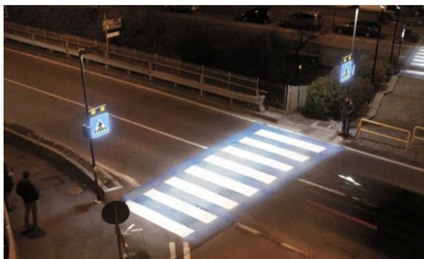
Рисунок 3.3 – Пример дополнительного освещения на пешеходном переходе
