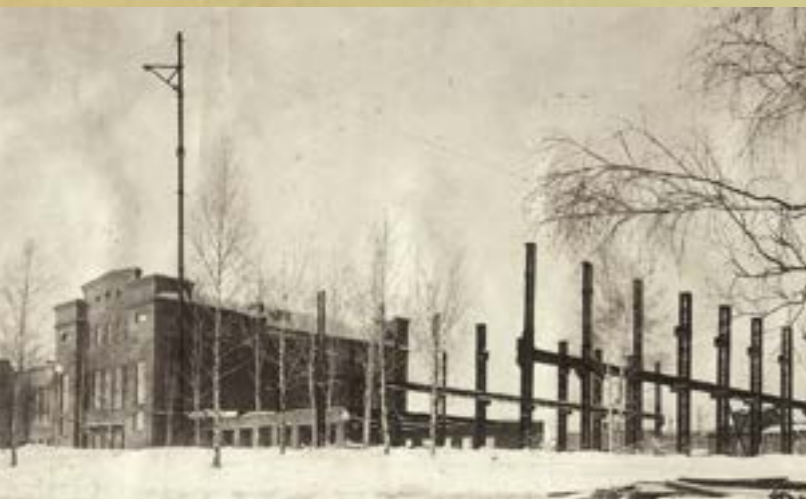
Строительство корпуса № 1 ЦАГИ (левое крыло)
