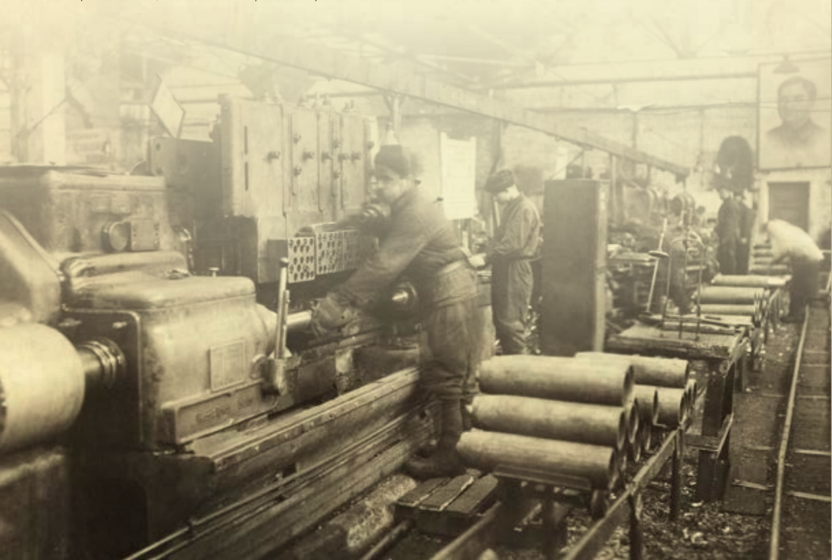
Поточное производство на заводе № 65 имени Сталина. Производство 122-мм осколочно-фугасной гаубичной гранаты. Общий вид потока чернового передела
