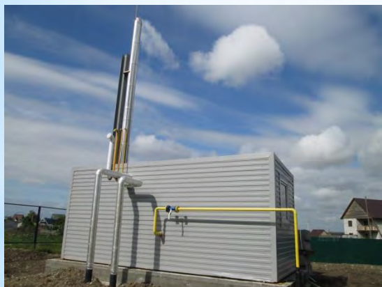
Ввод в эксплуатацию блочно-модульной газовой котельной тепловой мощностью 0,31 МВт. к многоквартирным домам по ул. Юбилейная 5а и 5б в р.п. Коченево
