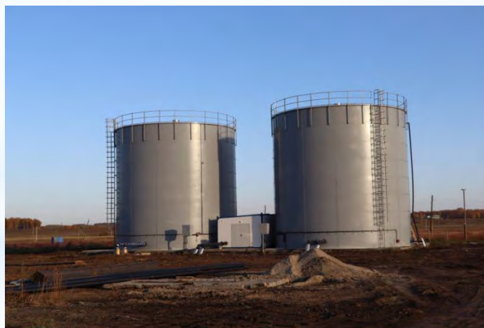
Строительная площадка комплекса объекта по водоочистки и водоподготовки в р.п.Коченево.
